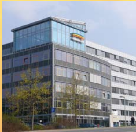
Noch im Dezember wird auf dem Dach des Stadtwerke-Hauptsitzes Sonnenstrom erzeugt.
