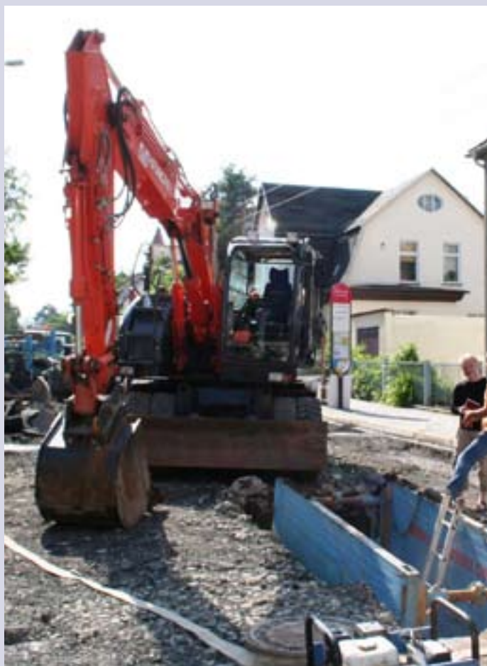
Baustart in der Humboldtstraße.
