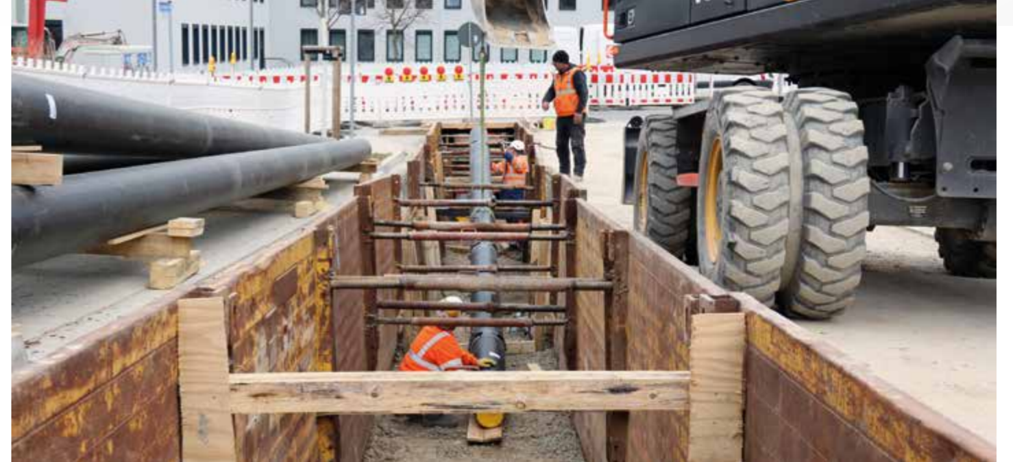
Auf der Baustelle in der Naumberger Straße werden die neuen Gasleitungen gut verpackt unter der Erde verlegt.
