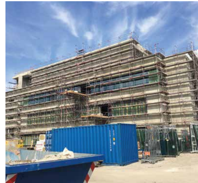
Rund 100 Millionen Euro investiert Everpharma bis 2020 in seinen neuen Standort im Gewerbegebiet JenA4. Für die umfangreichen Elektroinstallationen ist die ASI verantwortlich.
