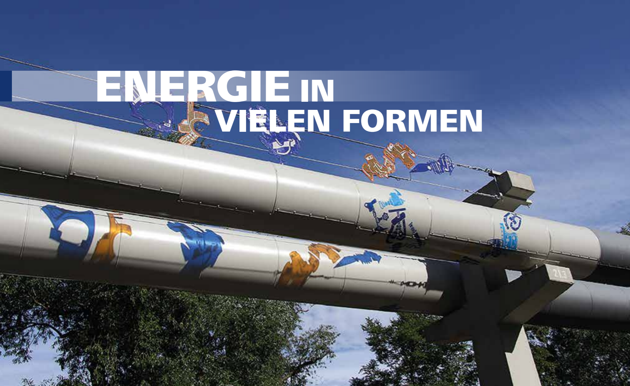
Projekt 24 der „Adern für Jena“: Ein EnergieTor, das nachts leuchtet.
